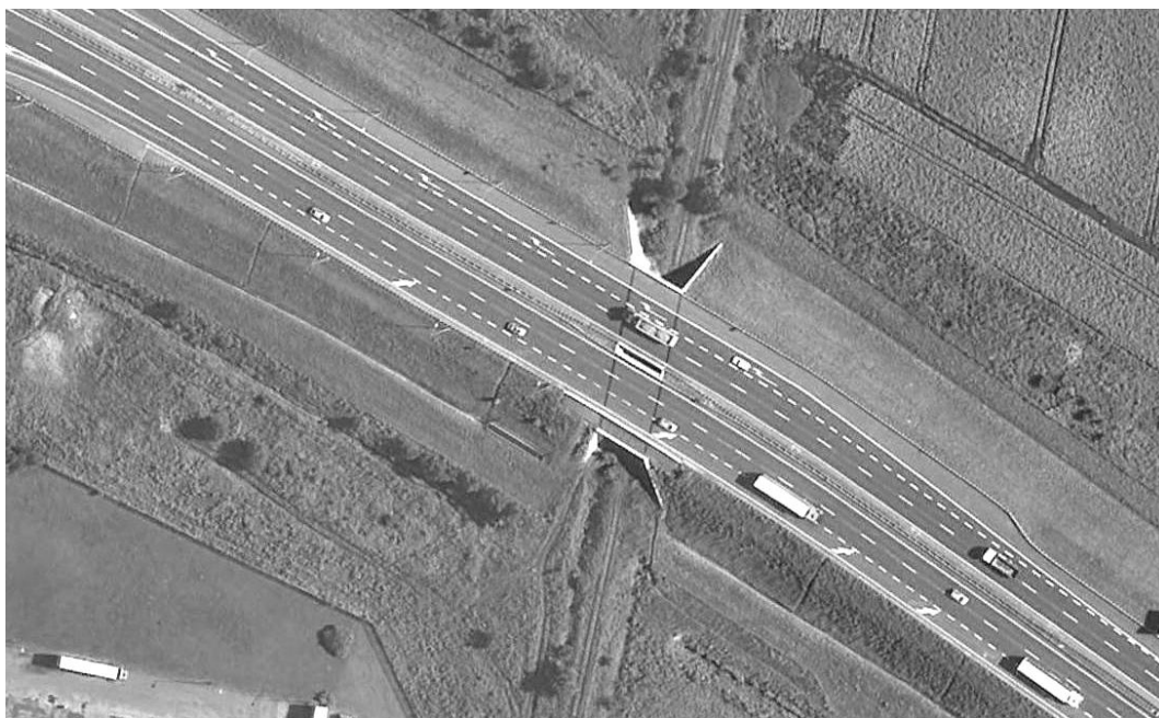
Rys. 4.3. Dwie jezdnie po dwa pasy ruchu i dodatkowe pasy ruchu na autostradzie [21]
