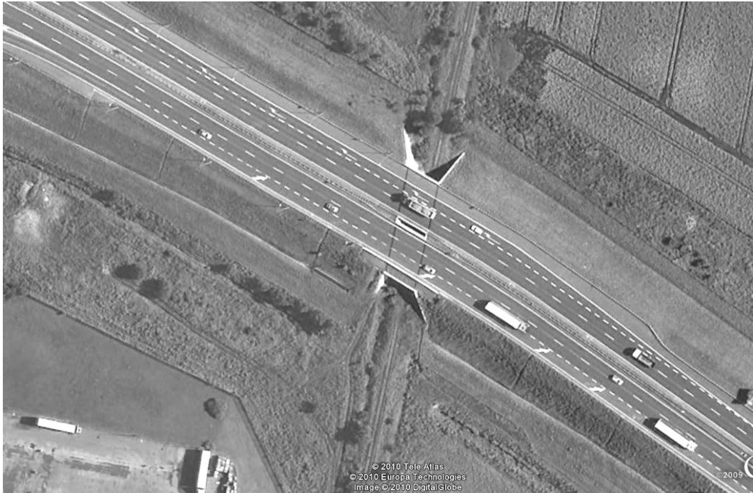
Rys. 4.3. Dwie jezdnie po dwa pasy ruchu i dodatkowe pasy ruchu na autostradzie [19]
